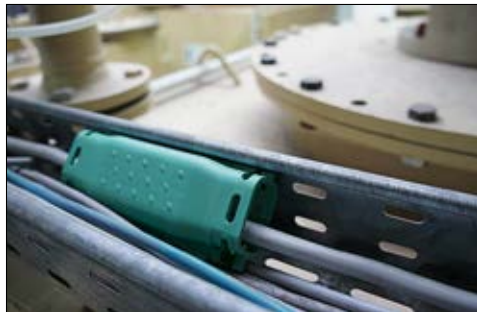
Gel-Kabelgarnitur Relifix V als Kabelverbindung.
