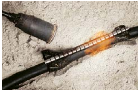
RMS für die Reparatur von nur teilweise erreichbaren Kabeln.
